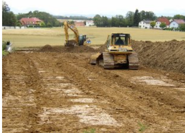
Erdbewegungsarbeiten am Übungsplatz
