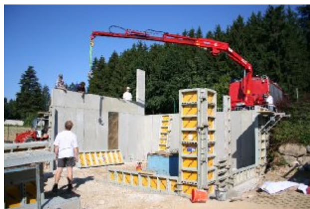
Schalungsarbeiten mit dem Feuerwehrkran
